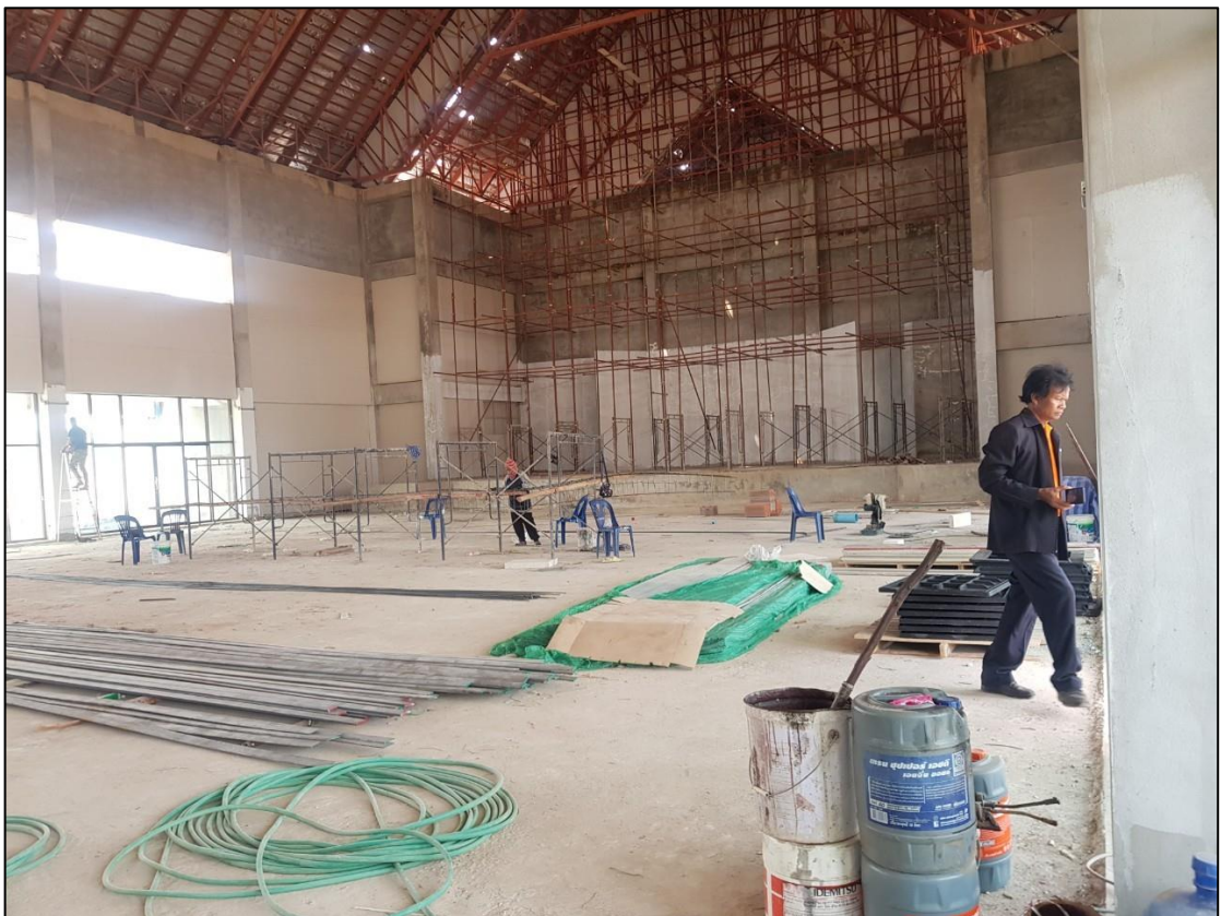
ภาพที่ ๔ บริเวณภายในอาคารอเนกประสงค์
