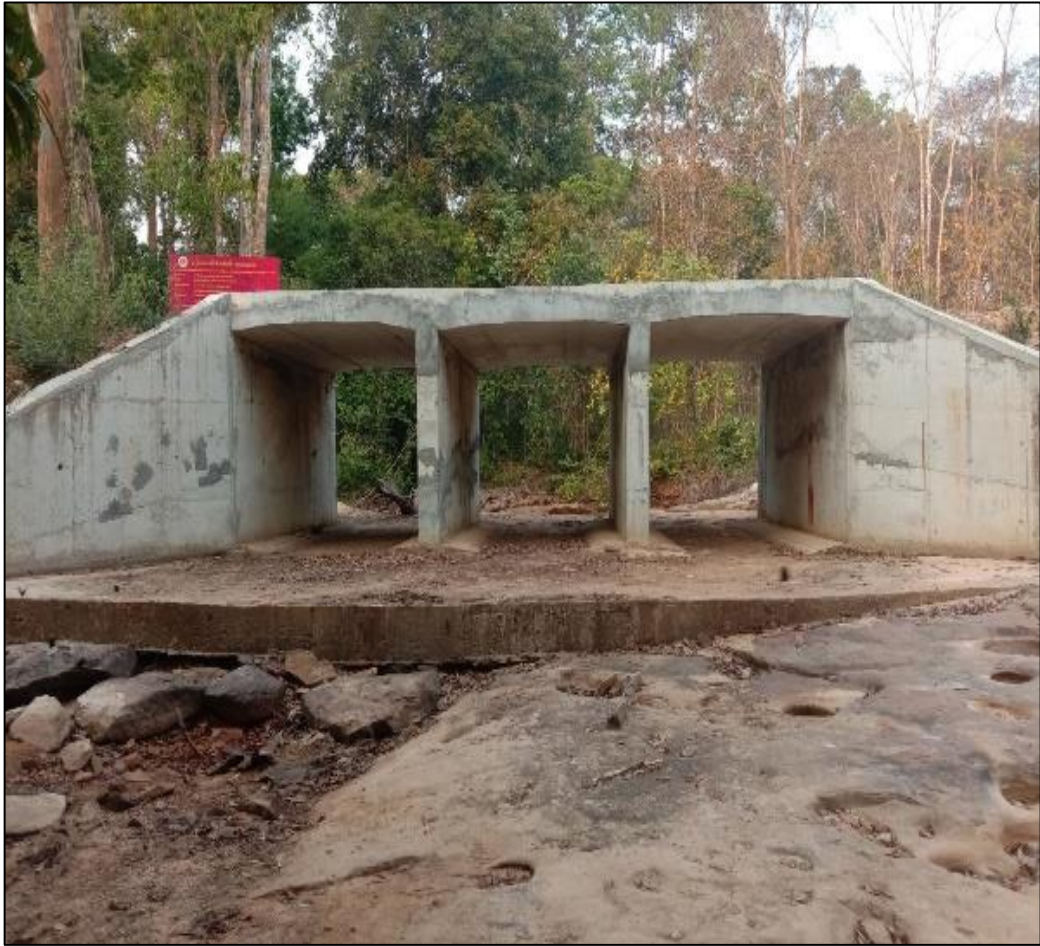
ภาพที่ ๕ ก่อสร้างท่อลอดเหลี่ยม (Box Culvert) ข้ามห้วยทางขึ้นภูหินด่าง อำเภอบุณฑริก
