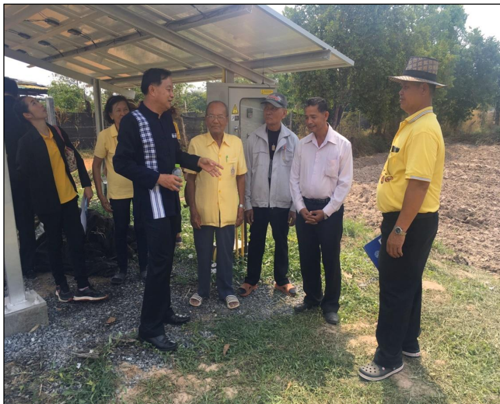
ภาพที่ ๒ บริเวณพื้นที่ก่อสร้างฐานรองรับแผงโซล่าเซลล์ จำนวน ๒๕ ชุด
