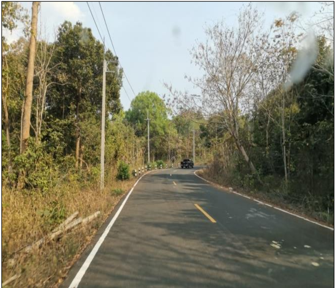
ภาพที่ ๔ ขยายเขตระบบจำหน่ายไฟฟ้าและติดตั้งหม้อแปลงไฟฟ้าบริเวณฐานอนุพงศ์ (สมรภูมิช่องบก)
