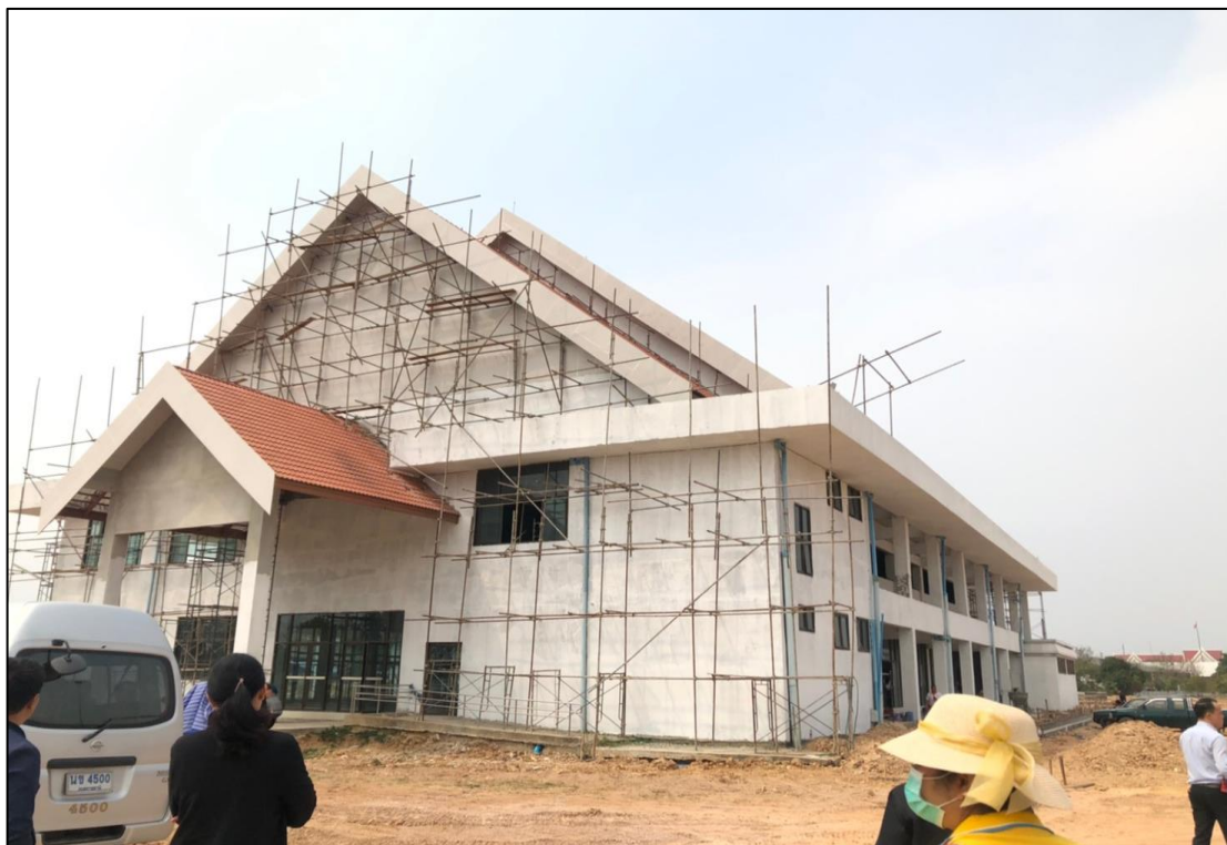
ภาพที่ ๑ บริเวณพื้นที่ดำเนินการก่อสร้างอาคารอเนกประสงค์
