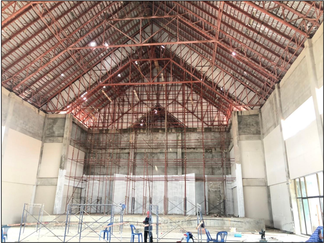
ภาพที่ ๓ บริเวณภายในอาคารอเนกประสงค์
