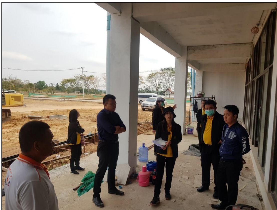
ภาพที่ ๒ บริเวณพื้นที่ดำเนินการก่อสร้างอาคารอเนกประสงค์
