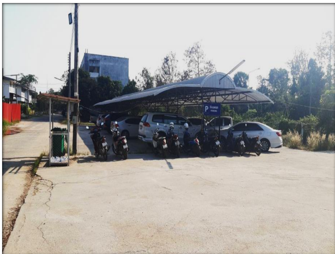
ภาพที่ ๒ พื้นที่ก่อสร้างสิ่งปลูกสร้างพร้อมครุภัณฑ์ โรงพยาบาลเบญจลักษณ์ บริเวณลานจอดรถ
