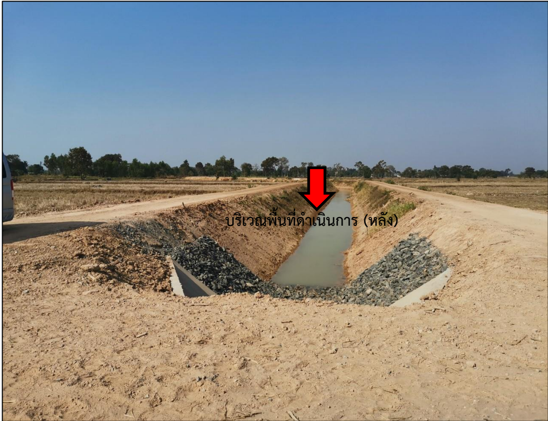
ภาพที่ ๓ บริเวณพื้นที่ดำเนินการ (หลังดำเนินการ)
